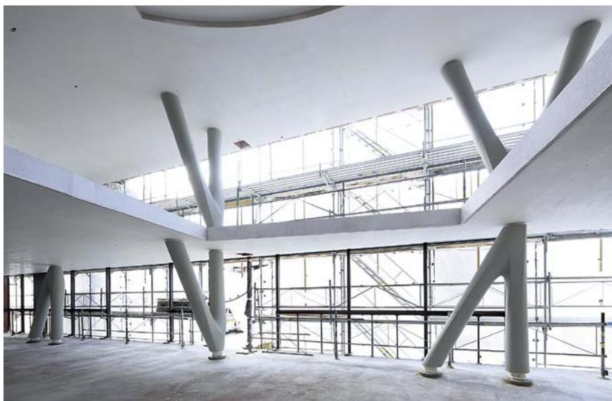
In der Bauphase waren die A- und V-förmigen Stützen besonders gut sichtbar, doch auch im fertigen Gebäude sind sie nicht verborgen
