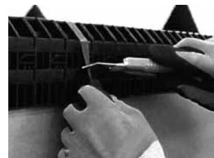
1 - Ecartez le film plastique et découper le au cutter. Assurer vous que la lame n'entre pas en contact avec les panneaux pour ne pas les endommager.
