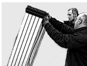
5 - Les 5 derniers panneaux doivent être basculés horizontalement par 2 personnes.
