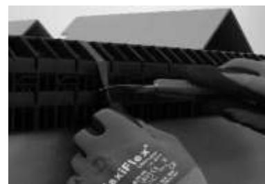
1. Pak eerst de folie en knip deze open met een cuttermes. Zorg ervoor dat het blad geen contact maakt met een van de panelen om ze niet te beschadigen.
