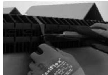
1. Zunächst die Folie greifen und mit einem Cuttermesser aufschneiden. Achten Sie darauf, dass die Klinge des Cuttermessers die Solarmodule nicht berührt.
