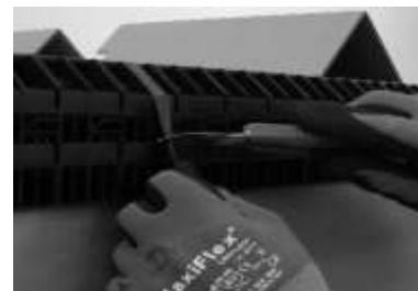
1. Ecartez le film plastique et découpez le au cutter. Assurez-vous que la lame n'entre pas en contact avec les panneaux pour ne pas les endommager
